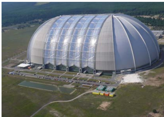
Neben der einstigen CargoLifter Halle soll ein Feriendorf entstehen.
